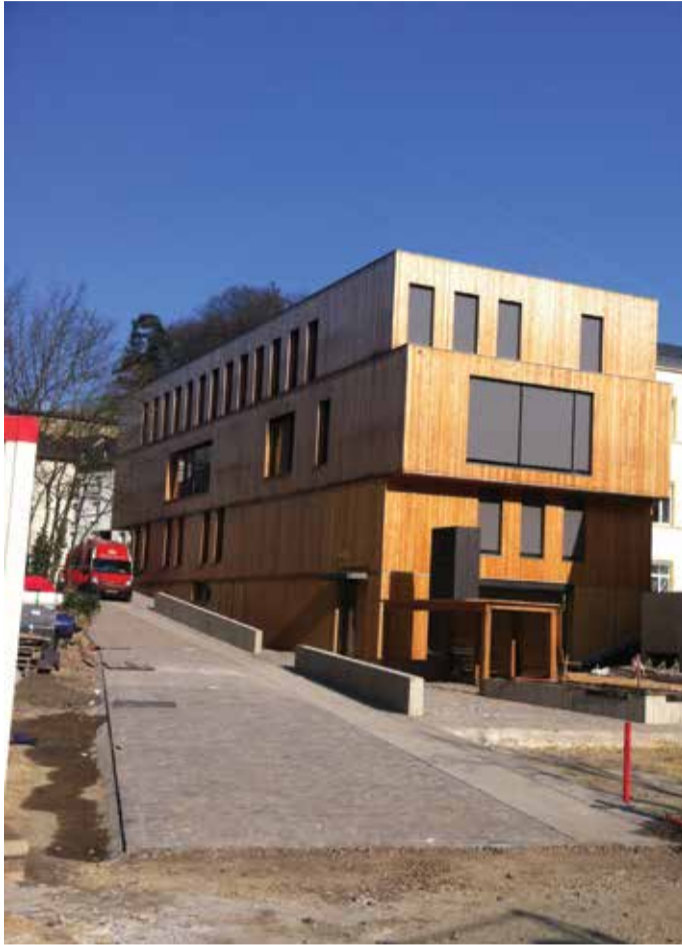
Ansicht des neuen Oekozynters von der Alzette aus gesehen mit im Untergeschoss der Cafeteria samt Terrasse und im 1. Stock den großen Fenstern des Konferenzraumes.
